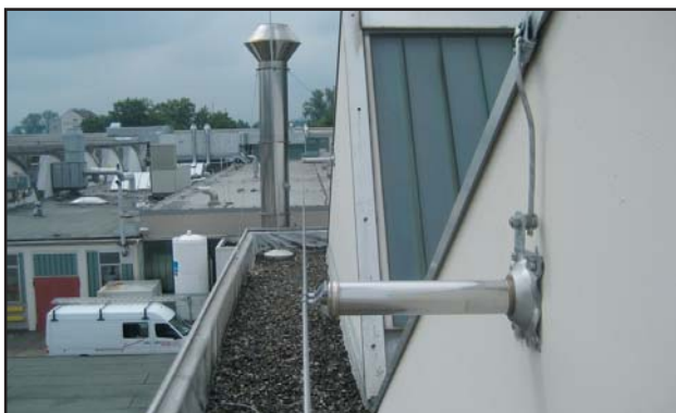
Falra szerelhető Seculine® Vario rendszer nemesacél kötéllel
