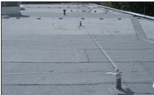
Átjárható Seculine® Vario rendszer, nemesacél kötéllel
