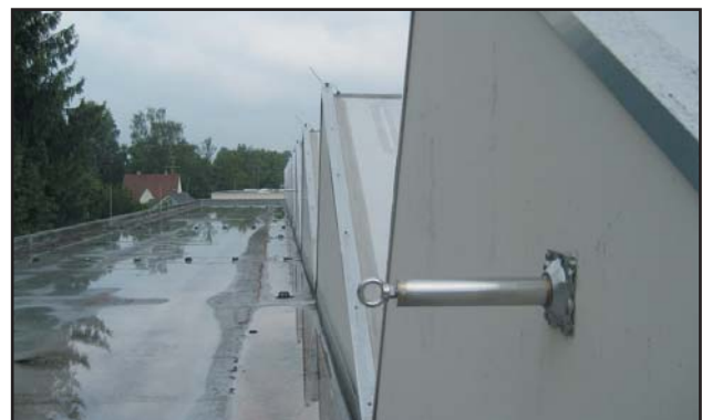
Falra szerelhető Seculine® Vario egyedi rögzítési pontként
