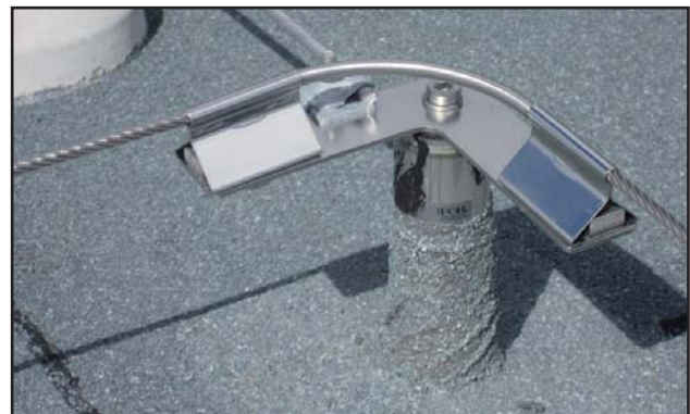
Seculine® Vario sarokfordító elem csatlakoztatott villámvédő körvezetékekkel
