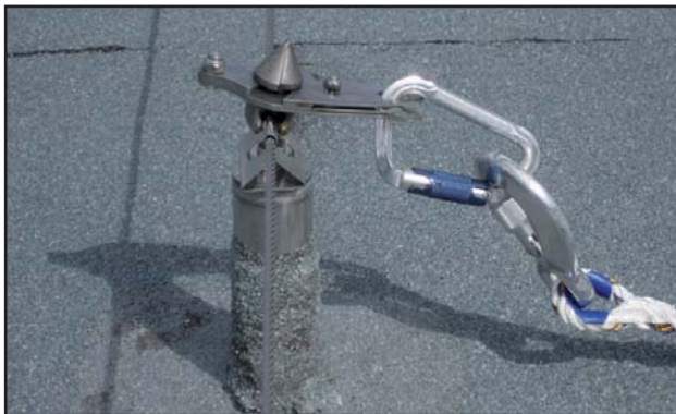
Átjárható Seculine® Vario rendszer, futóelemmel
