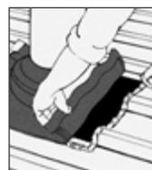
5. Dichtungsmasse auftragen und DEKTITE® formgenau an Profileblech anpassen.
