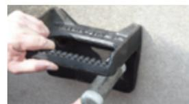
3. Steigeisenanker durch die Bohrung im Steigeisen im Durchsteckverfahren setzen.
